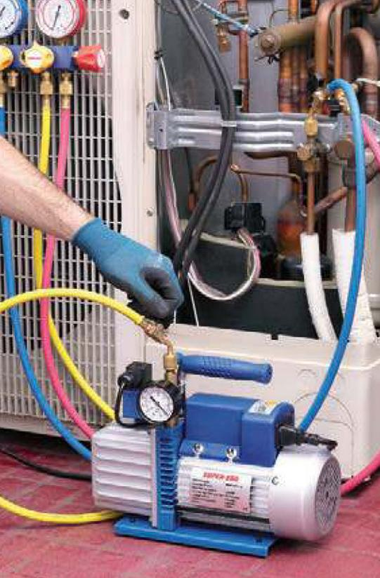
Вакуумметр Ø 54 мм для простого и быстрого контроля процесса слива хладагента из системы
