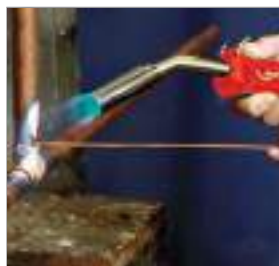
Пайка твердым припоем
