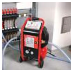
Промывка системы отопления пола
