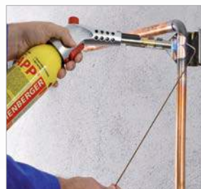
Пайка твердым припоем при монтаже системы газоснабжения
